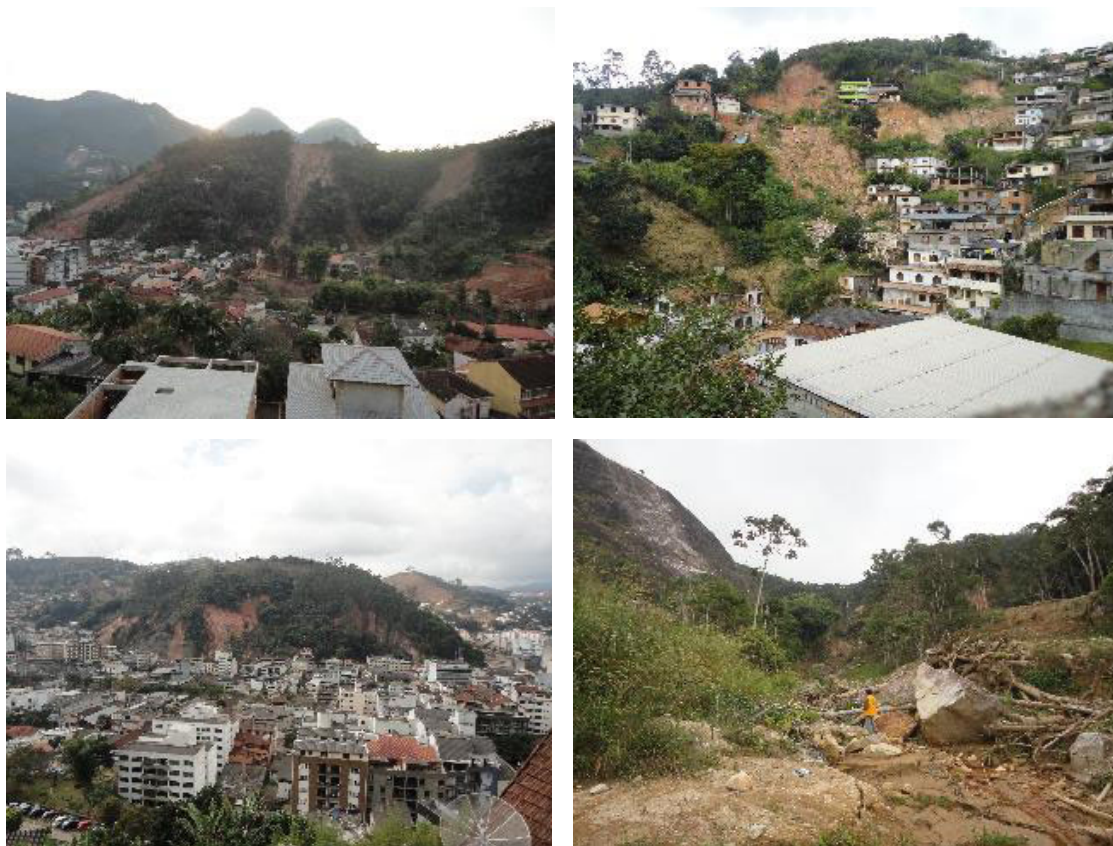
Figura 3. Três áreas densamente ocupadas em Nova Friburgo que sofreram grandes deslizamentos em 2011, ocasionando muitas mortes. Na foto abaixo a esquerda, se observa a cicatriz de um grande deslizamento ocorrido à época na bacia do Córrego d'Antas.
