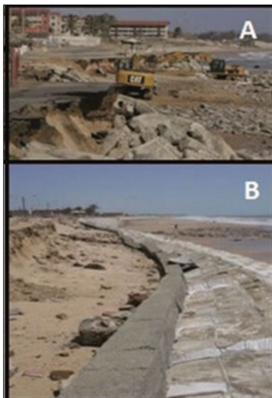
Figura 6. (A) Erosão na Praia do Icarai, situada 25 km a sotamar do Porto do Mucuripe, a qual resulta das intervenções realizadas no litoral de Fortaleza e nas áreas em torno do Porto do Mucuripe. A ascensão mundial do nível do mar também deve ser um fator produtor dessa erosão. (B) Bag-wall instalado na Praia do Icarai nos anos 2010, já destruído pelas ondas.
