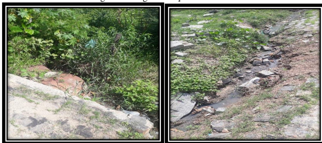
Imagem 01: Esgotos lançados em terreno
