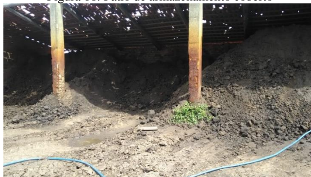
Figura 06: Pátio de armazenamento coberto
