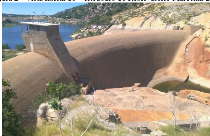
Figura 2 - Vista lateral do Vertedouro do Reservatório Marechal Dutra
