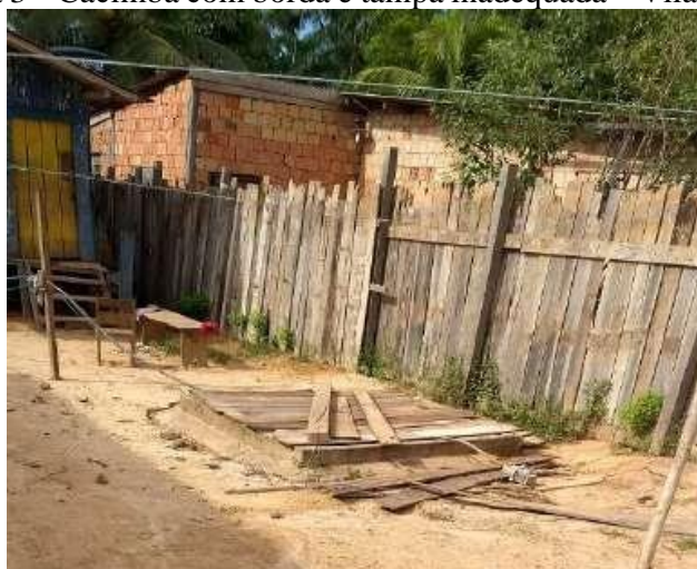
Figura 3 – Cacimba com borda e tampa inadequada – Vila Canoas
