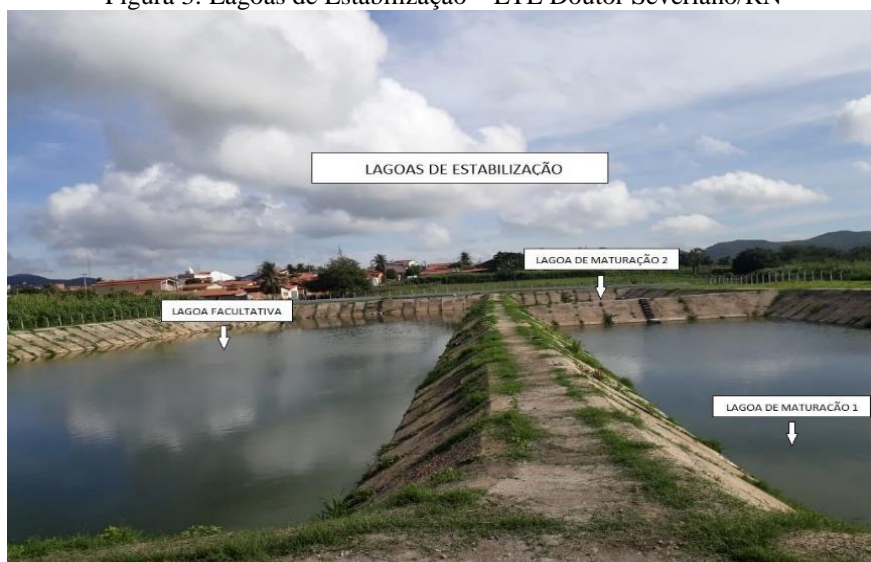
Figura 3: Lagoas de Estabilização – ETE Doutor Severiano/RN
