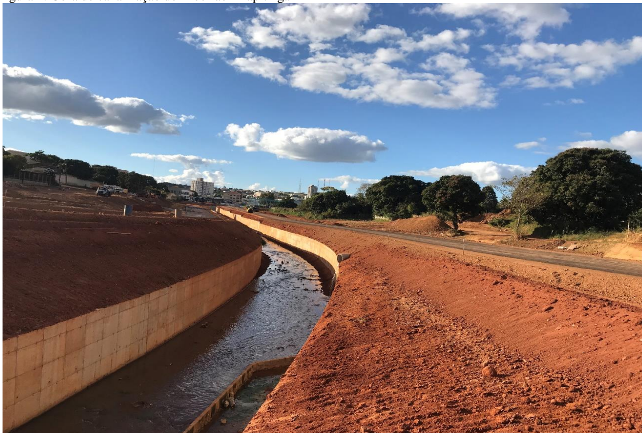
Figura 4: Obra de canalização do Ribeirão Pirapitinga
