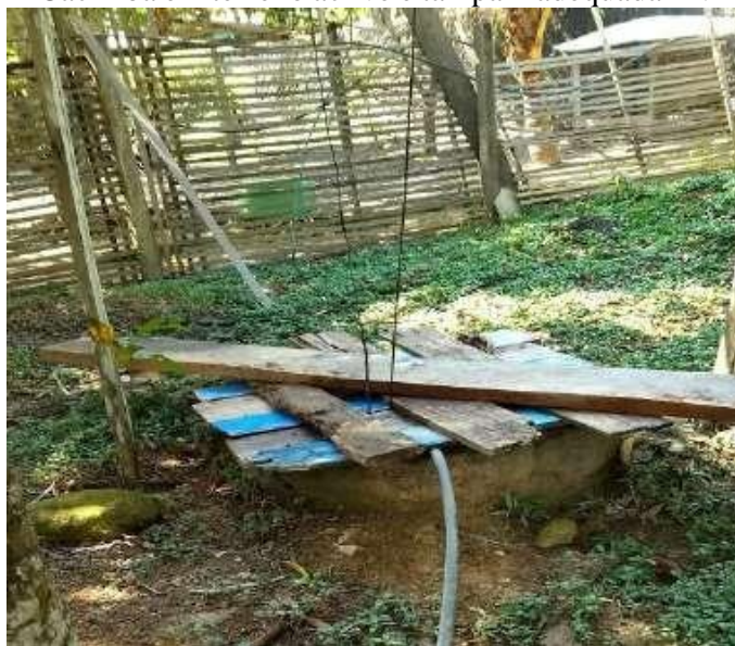
Figura 4 – Cacimba em terreno aclave e tampa inadequada – Vila Canoas
