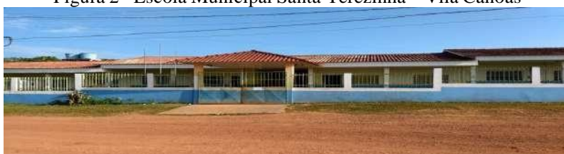
Figura 2 - Escola Municipal Santa Terezinha – Vila Canoas
